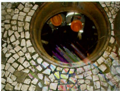
Figura 1 - Abertura de um espaço confinado
