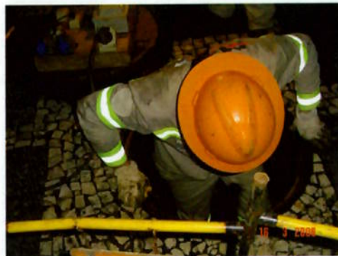
Figura 2 - Descida em espaço confinado
