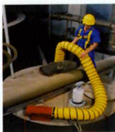
Figura 16 – Posicionamento de tubulação de exaustor
