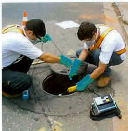
Figura 22 – Monitoramento do interior do espaço confinado antes do acesso.
